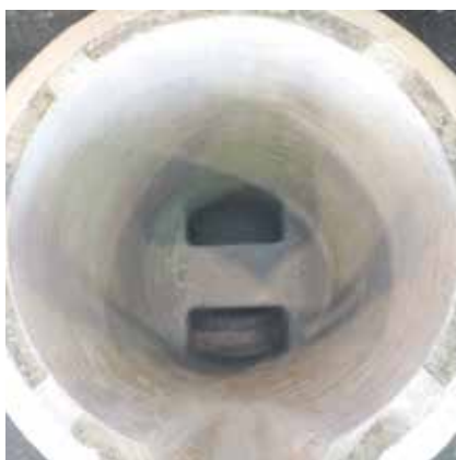
耐火物施工後
